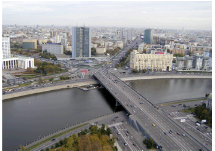
Bild 12: Blick auf den Neuen Arbat
