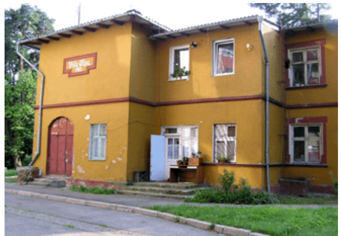
ehemalige Pension Elise, heute Wohnhaus
